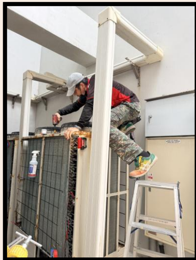
海域中心冷氣機室外機機板模組更新及冷媒管修復
